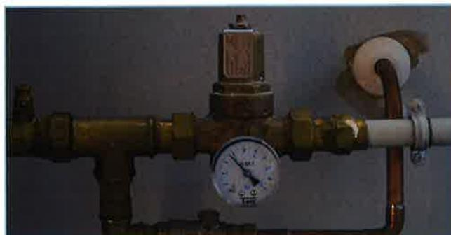
**Stabilité de la pression :** Le réducteur maintient une pression d'eau stable et constante, ce qui améliore le confort d'utilisation, notamment sous la douche, aux robinets, et lors de l'utilisation des appareils ménagers.
